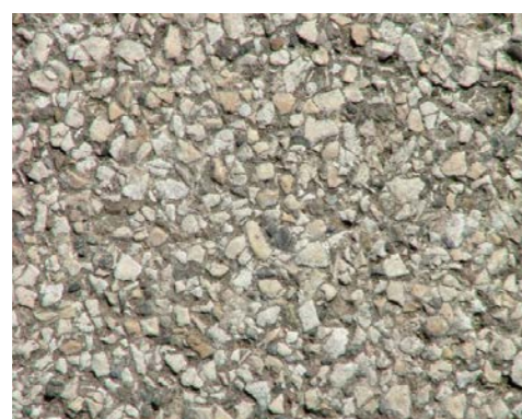
WEGE + PLÄTZE HELLER ASPHALT
